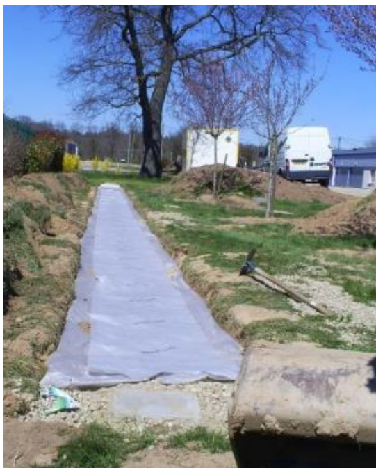
Fermeture du géotextile
