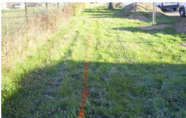
Marquage au sol
