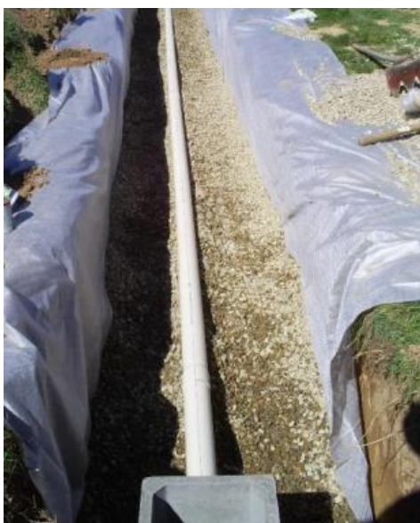
Pose du regard de décantation et du drain à 2/3 de la hauteur de graviers
