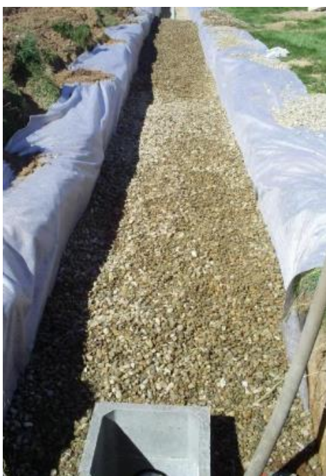
Pose du regard de décantation et du drain à 2/3 de la hauteur de graviers
