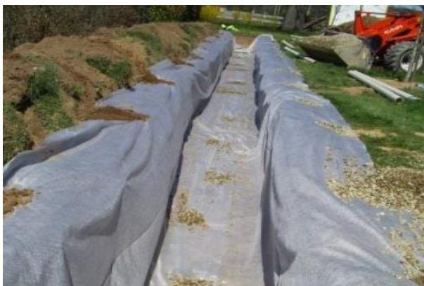
Mise en place du géotextile
