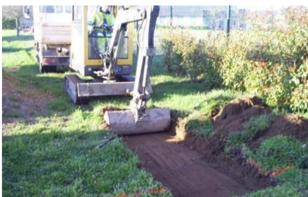
Décapage de la terre végétale
